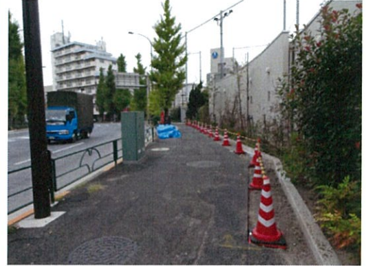
工事箇所(I)
