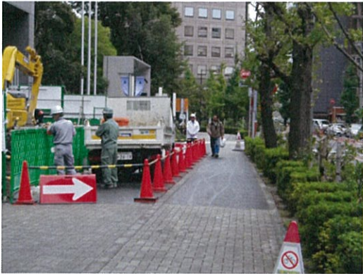
工事箇所(M)
