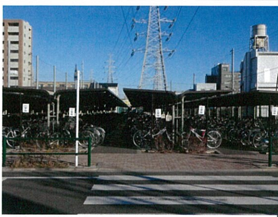
自転車駐輪場(全景)
